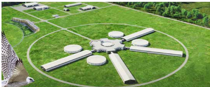
Строительство объекта «Зоопитомник «Международный центр реабилитации, репродукции и сохранения ред- ких видов птиц на Камчатке»
